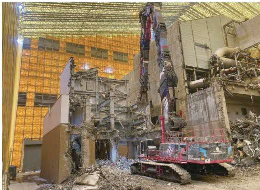
仮設テント内での解体工事(江戸川清掃工場)
