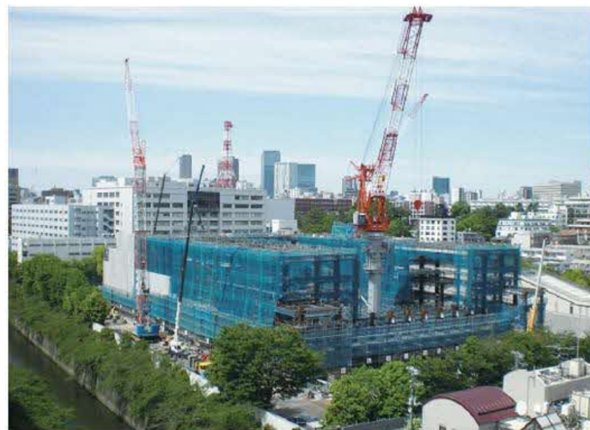
建設工事の全景(目黒清掃工場)
