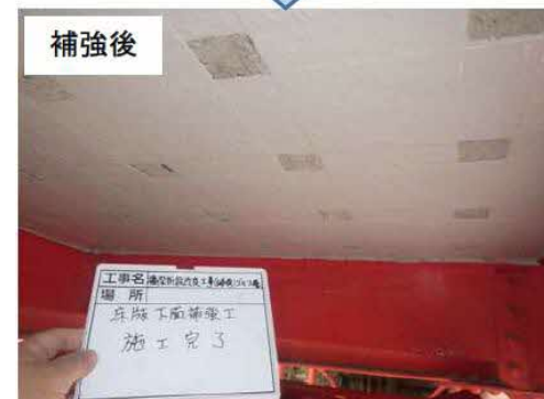
コンクリート床版補強 (炭素繊維シート接着)
