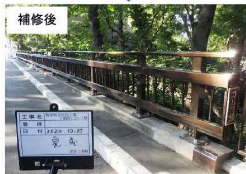
高欄取り換え
