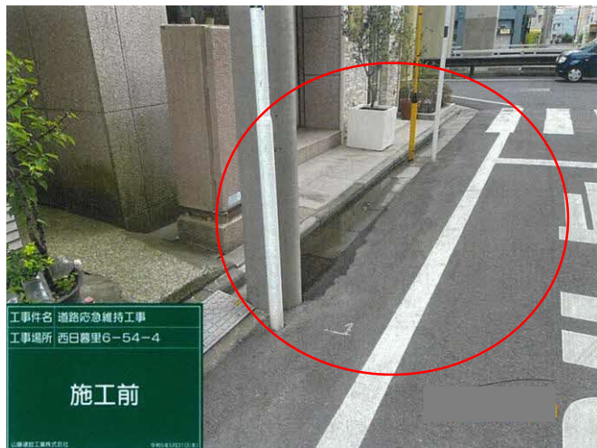
例) L形側溝の水たまり解消
